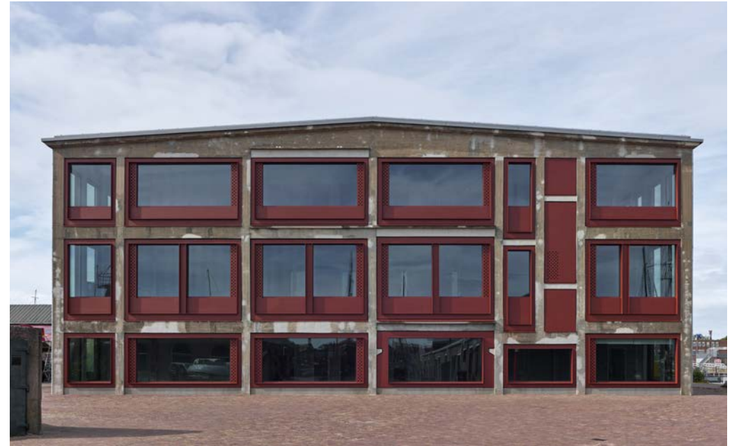
De nieuwe zuidgevel gebouw 72
